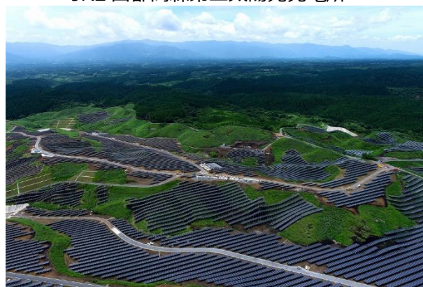
JRE 山都高森第二太陽光発電所
